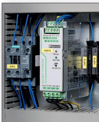
Afbeelding 6. De voeding met bijbehorende beveiligingen.
