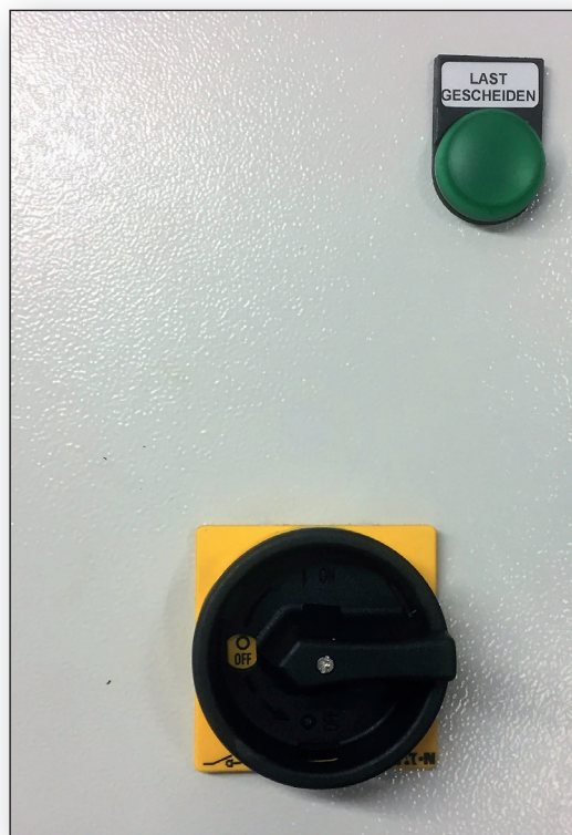
Afbeelding 9. De werkschakelaar met groene lamp.
