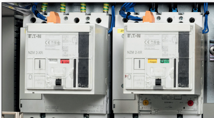
Afbeelding 2. Rechts de motorbediende vermogensautomaat en links de kortsluitvermogensautomaat van Eaton.
