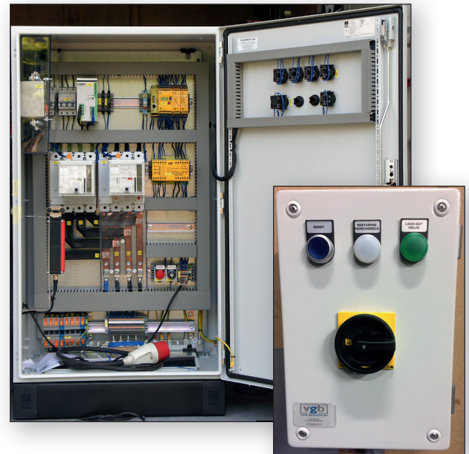
Afbeelding 3. Prototype 100 kW basis- en remote-unit met intrinsiek veilige werkschakelaar.
